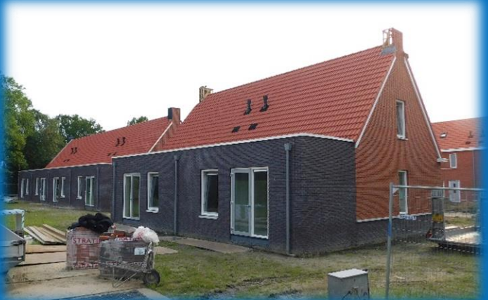
Foto's: In aanbouw zijnde woningen aan de Slotlaan
